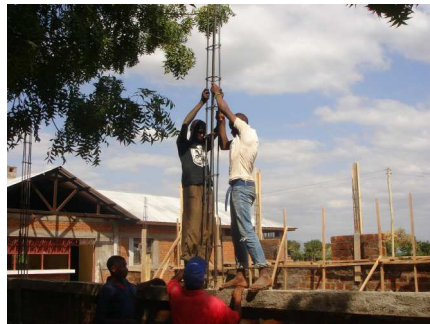
Fixieren der Pfeiler mit Eisen
