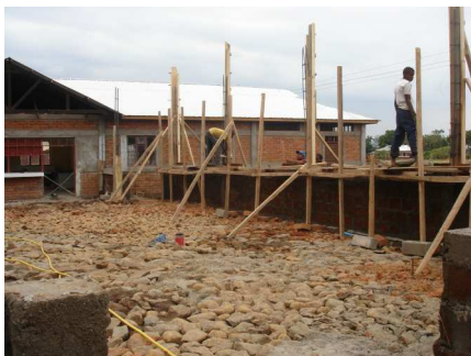
Der Boden wurde mit Steinen ausgelegt und steht zum Betonieren bereit
